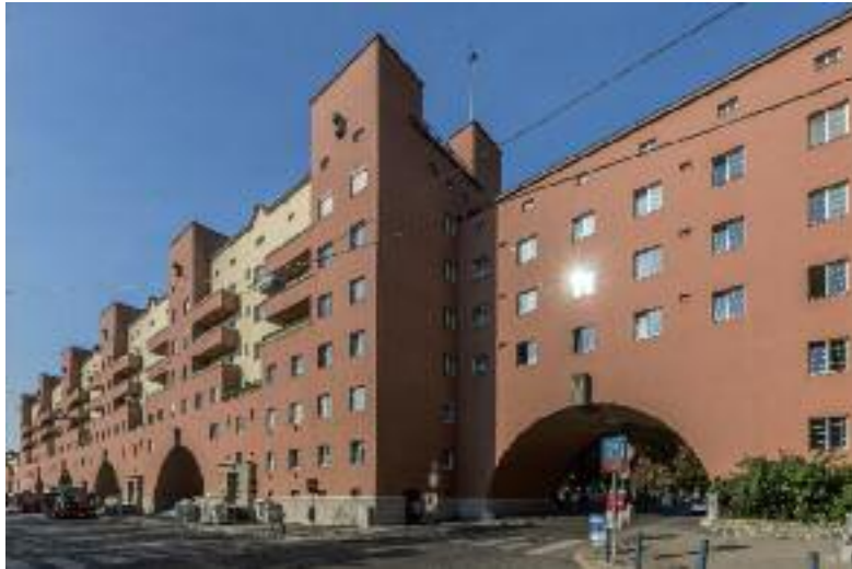
Der Karl-Marx-Hof, ein Gemeindebau im 19. Bezirk Wiens mit ursprünglich 1382 Wohnungen, wurde im Oktober 1930 bezugsfertig. Er gilt mit einer Front von einem Kilometer als der längste zusammenhängende Wohnungsbau der Welt
